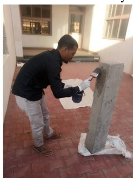
Application of epoxy primer
