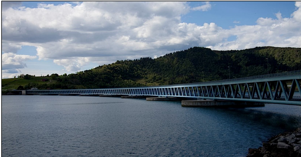
[Fig. 1. Bergsoysund Bridge]
