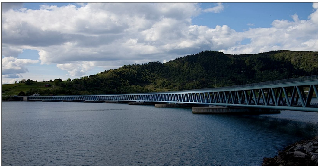
[Fig. 1. Bergsoysund Bridge]
