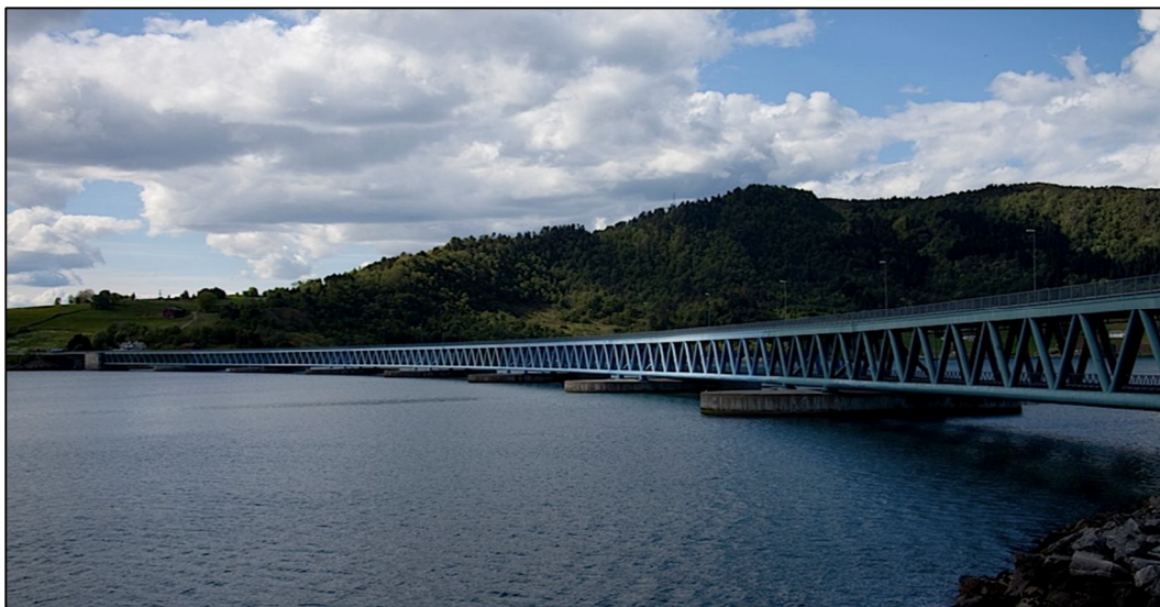
[Fig. 1. Bergsoysund Bridge]
