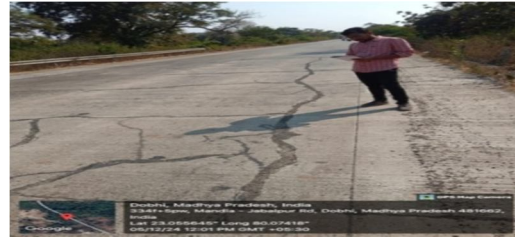
Longitudinal Cracks
