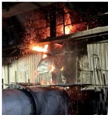
Fig. 4. Slag Leakage in Inlet Pipe
