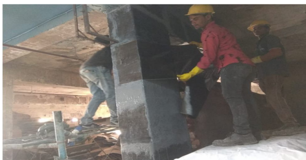
Fig. 1.3.1. Carbon Wrapping
