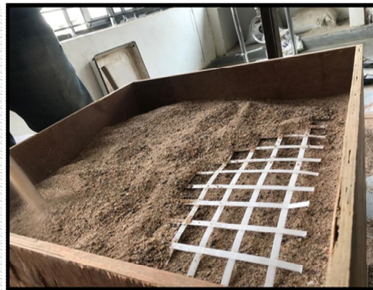
Pouring sand on reinforcement layer
