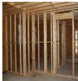
fig: timber frame
