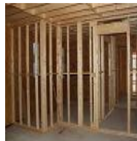
fig: timber frame
