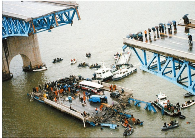
Fig. 2: Songsu Brige Collapse, Korea
